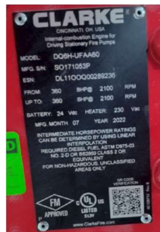
ป้ายชื่อเครื่องยนต์สูบน้ำดับเพลิง/Name Plate
